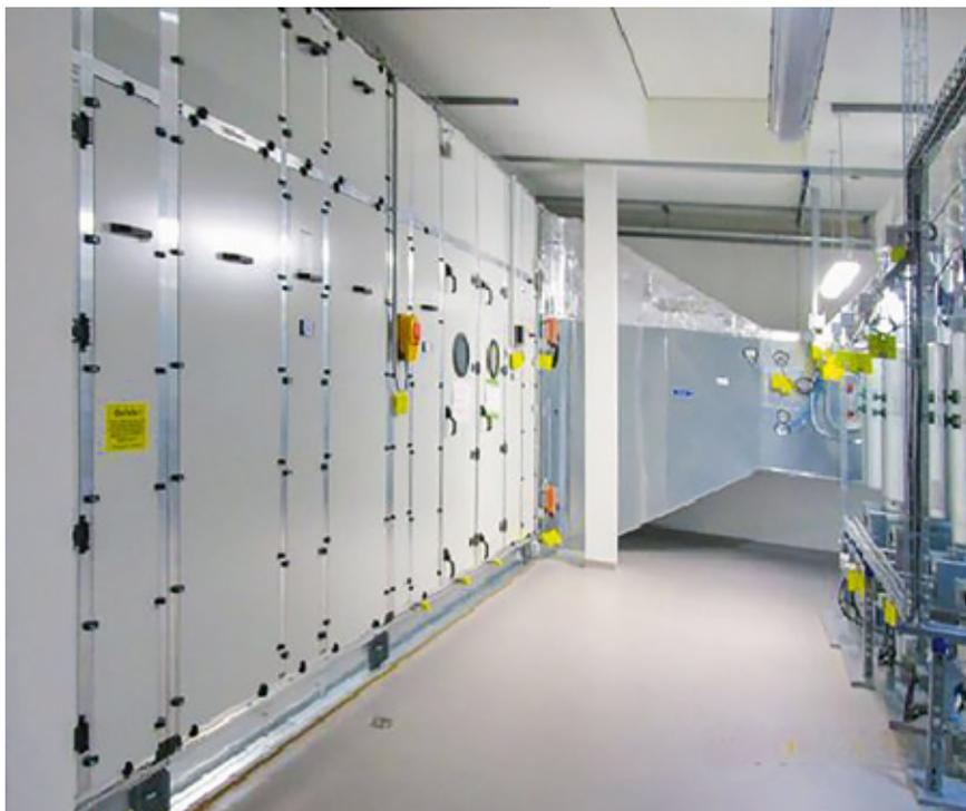
*Wichtigstes Element der Lüftungsanlage sind die Luftfilter, die im Rahmen der Wartung geprüft und gereinigt bzw. getauscht werden. Stimmt die Qualität nicht mit der geforderten überein oder ist die Verschmutzung zu gravierend, sind diese zu tauschen.*
